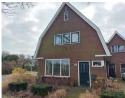
Kogelgaten in de muur.
